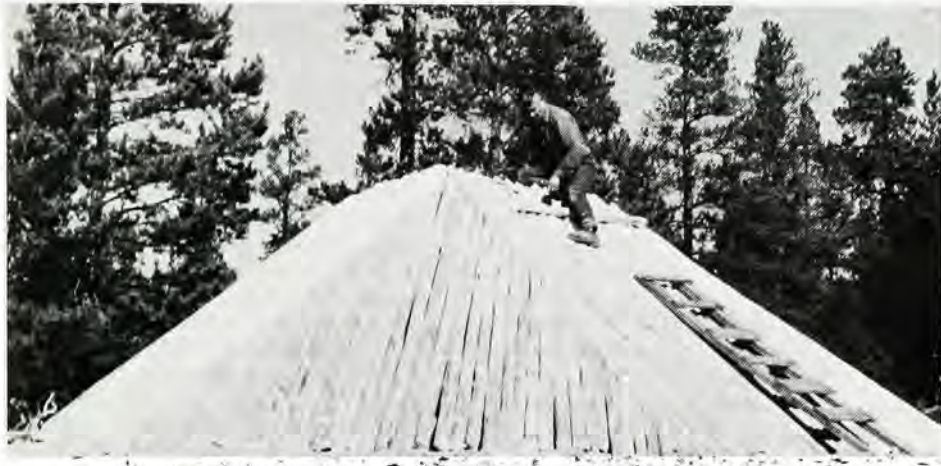
Restauration d'une maison semi-souterraine chilcotine sur le plateau de la Colombie-Britannique à Anahim Lake, réalisée suivant les renseignements archéologiques et historiques dont on dispose. Sur la photo, la charpente est terminée et toute la partie extérieure sera recouverte de gazon. On entrait dans ces habitations par le toit. ( Commission archéologique du Canada )
